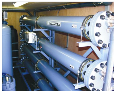
Omgekeerde osmose installatie type EUROTEC 03-12
