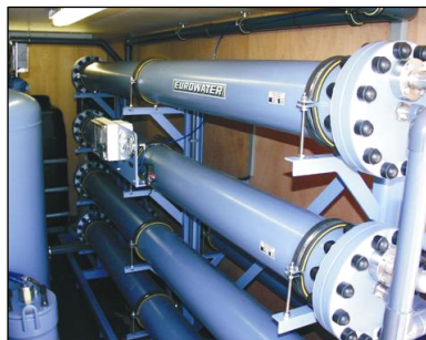
Omgekeerde osmose installatie type EUROTEC 03-12
