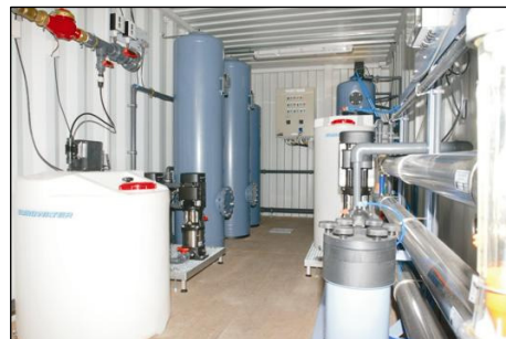
Diverse varianten zijn mogelijk in de verkoop van containers; bijvoorbeeld met doseerapparatuur, zand- en actief koolfiltratie. Wij bouwen flexibel en op maat!
