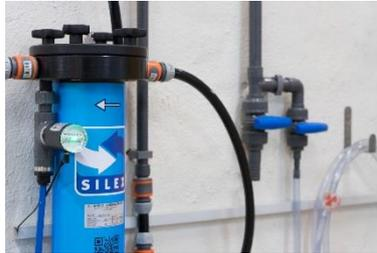
*SILEX 1C avec conductimètre intégré, qui indique en permanence la qualité de l'eau.*
