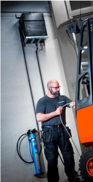
*Une solution assez simple pour la production d'eau de batterie comprend une unité SILEX, un réservoir d'eau et un équipement de prélèvement.*
